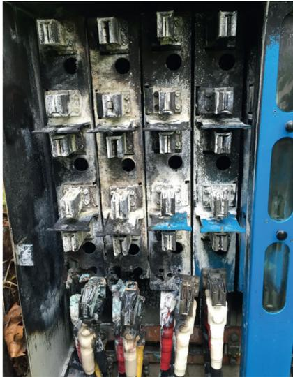
**Bild 6** Durch Kurzschluss beschädigte Schaltgerätekombination ohne korrekte Schutzauslösung.
